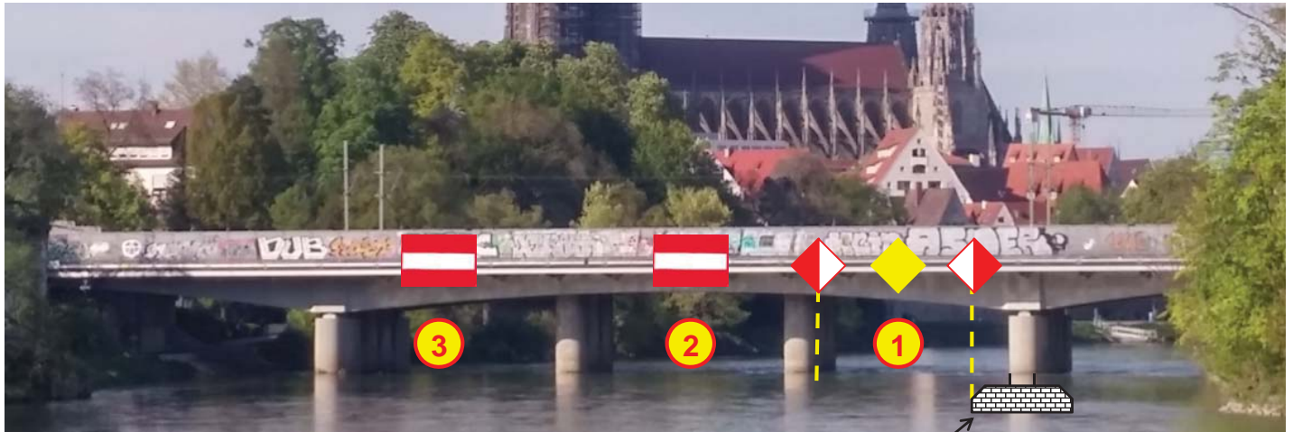
Brückenfundament unter dem Wasseroberfläche
